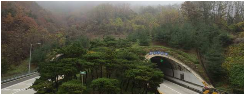
(1구간 시점부 절토사면 정면 전경)
