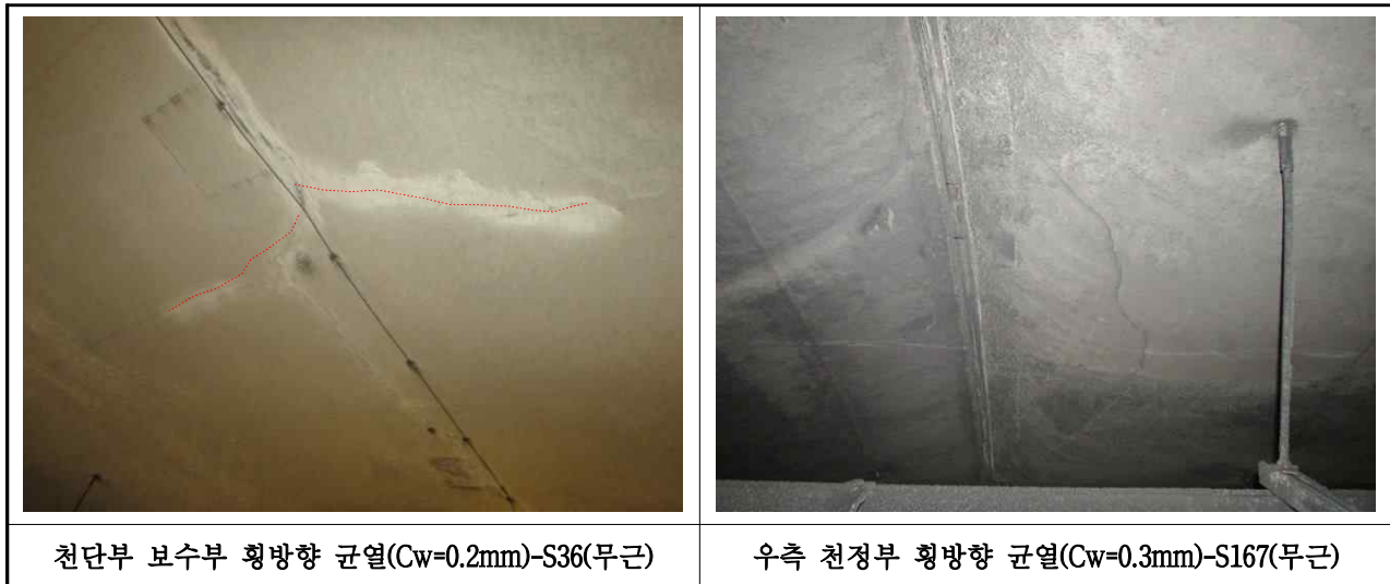
【사진 1.1.6】 라이닝 외관조사 결과(2)
