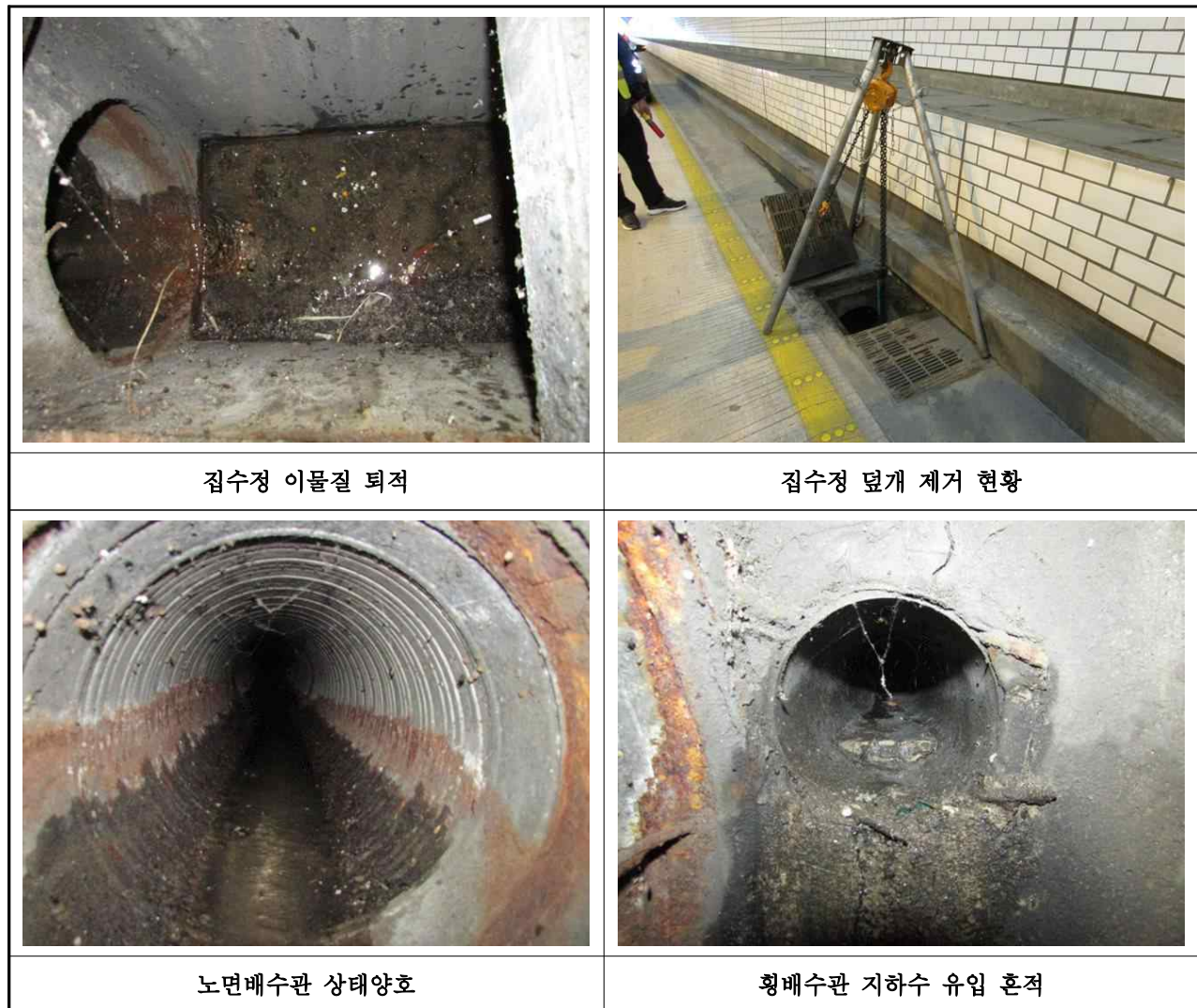
【사진 1.1.10】 배수시설 외관조사 결과
