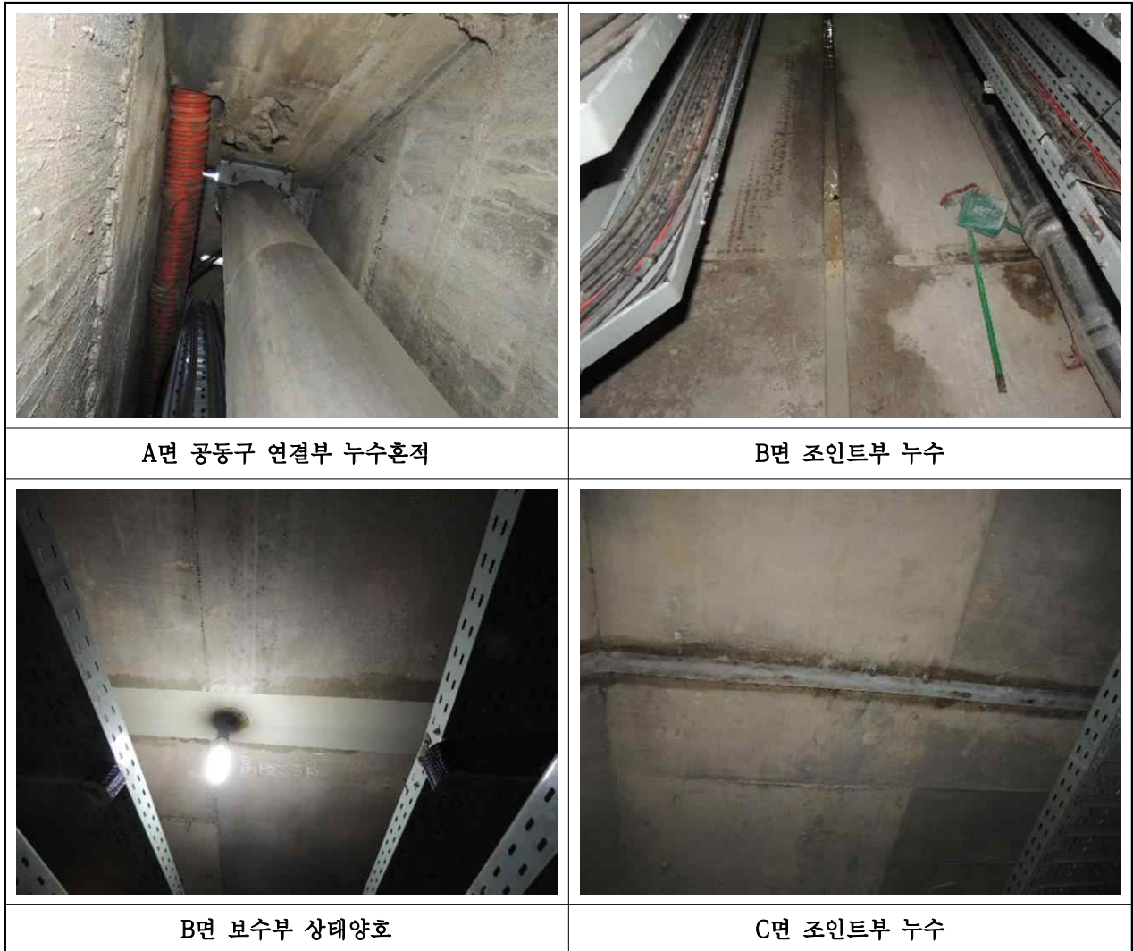
【사진 1.1.13】 옥외공동구 외관조사 결과
