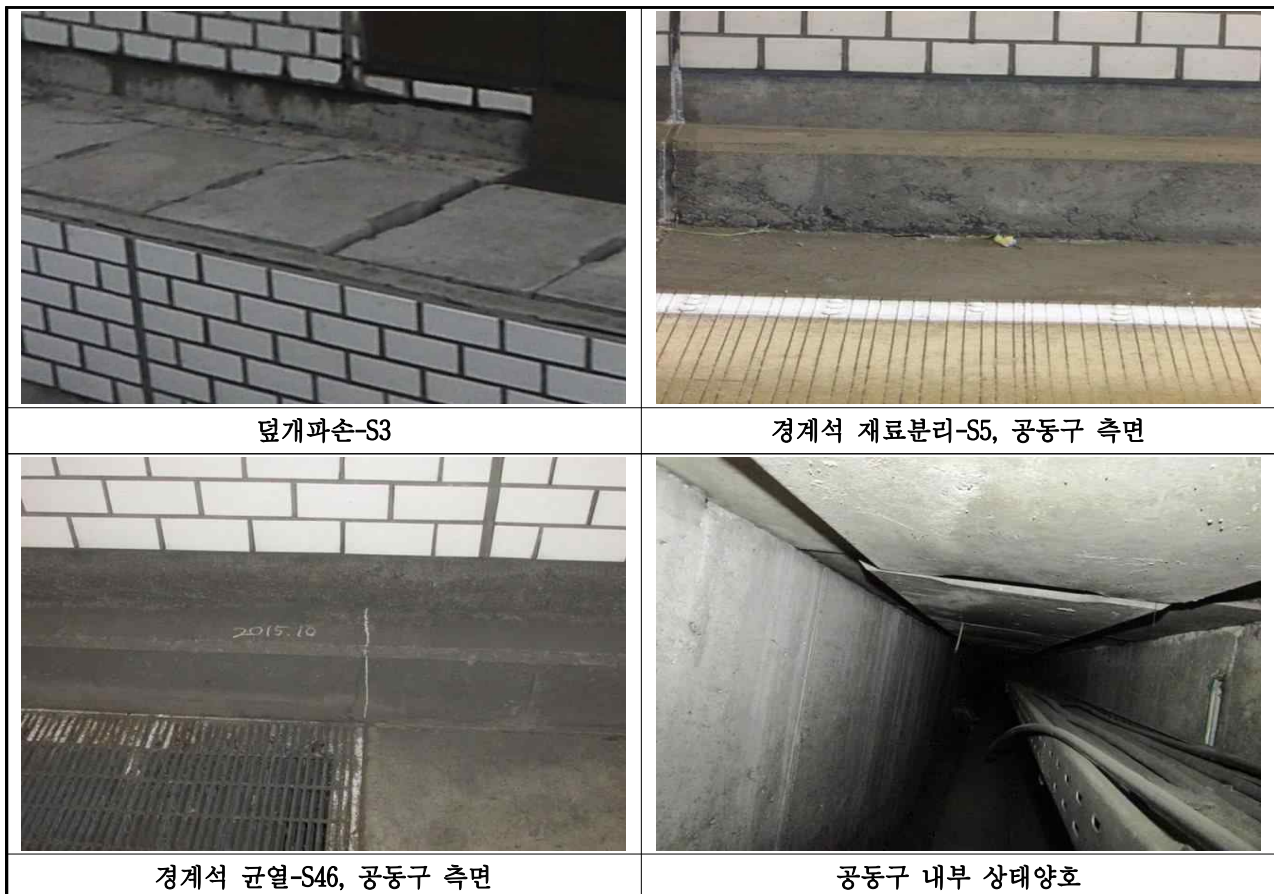
【사진 1.1.9】 공동구 외관조사 결과
